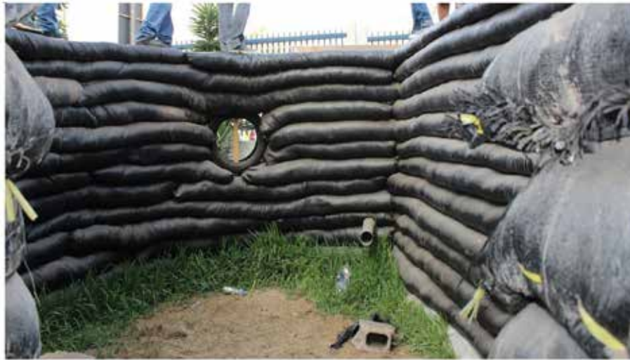
Figura 1. Proceso de construcción del prototipo de Eco-domo
