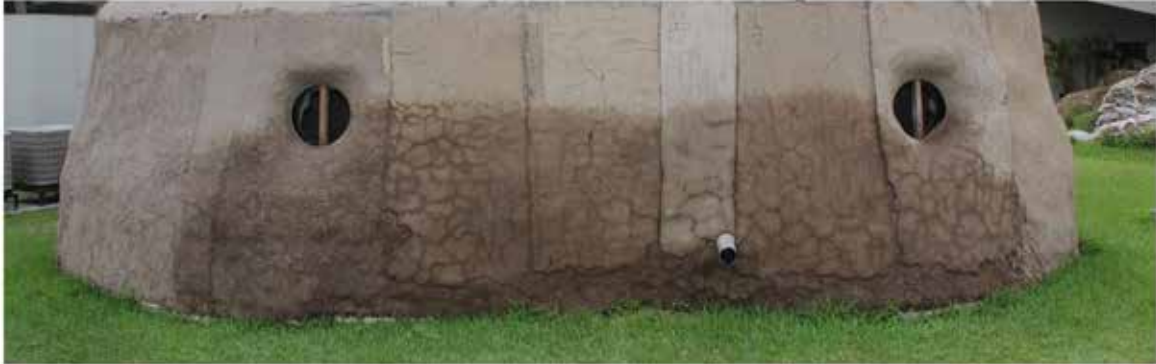
Figura 17. Pared exterior con varios tipos de acabado
