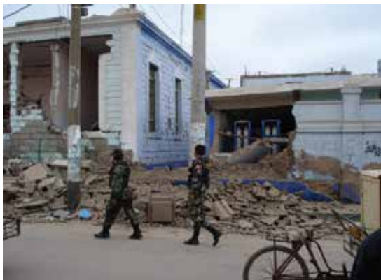
Figura 7. Hospital de la Ciudad de Pisco / confinamiento solo con ladrillos
