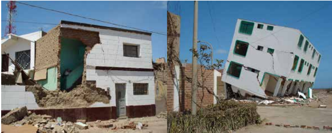
Figura 6. Autoconstrucciones de edificaciones
