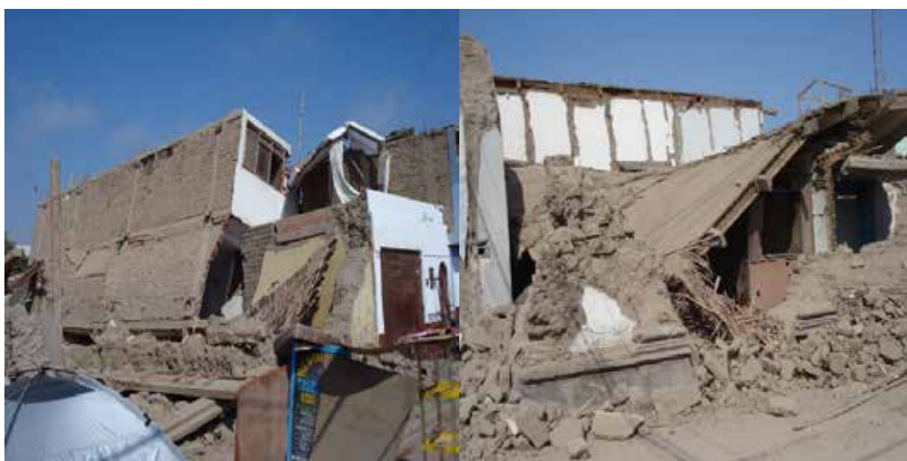
Figura 5. Edificación con deficiencia estructuración de columnas
