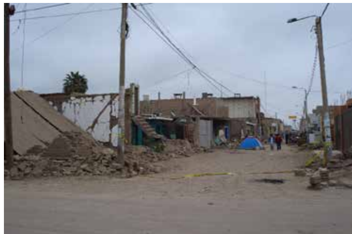
Figura 4. Construcción de viviendas sin supervisión profesional
